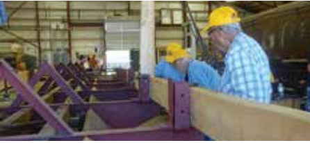
Proj. 1317: Reconstruction of Drop Bottom Gondola 731
