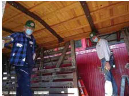
Proj. 1354: Restoration of Speeder MW-02
